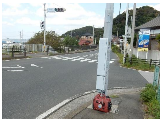
交通信号に自家発電機使用で仮復旧
