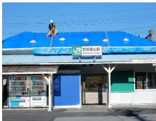
安房勝山駅の屋根仮復旧工事中
