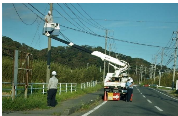
電線の架け替え工事中
